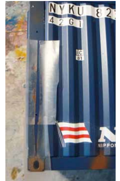
Mit Maskierfolie scharfe Kanten abgeklebt
