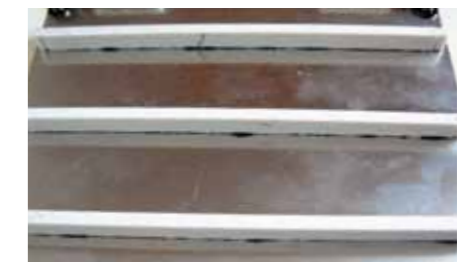
Verkleben der Unterzüge mit Sikaflex am Container-Boden
