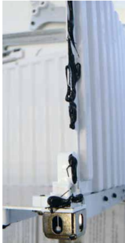
Sikaflex hält den Container schraubenfrei zusammen
